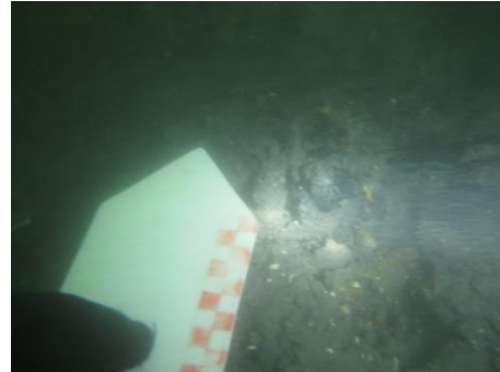
Figura 18 – Mergulho de inspeção visual
